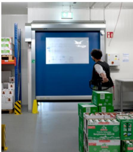
EFA-SST®-L Premium unterstützen diese Bemühungen der Genossenschaftsmolkerei in jederlei Hinsicht. Sie lassen die Kälte durch ihre sehr guten Isolierlamellen im Gebäude und reduzieren den Kälteverlust durch ihre schnellen Öffnungs- und Schliessgeschwindigkeiten sowie durch kürzeste Offenhaltezeiten von zehn Sekunden.
