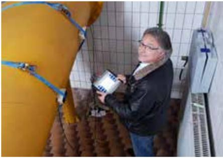
Wickelfalzrohr, Rohabwasser, lackiert: Keine einfache Aufgabe, funktioniert nach der automatischen Signaloptimierung aber tadellos. Bild: systec Controls
