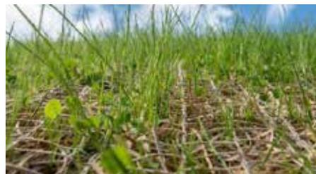
Die fertigen «Howolis»-Erosionsschutzvliese im Einsatz. Bild: Thomas Rickenmann
